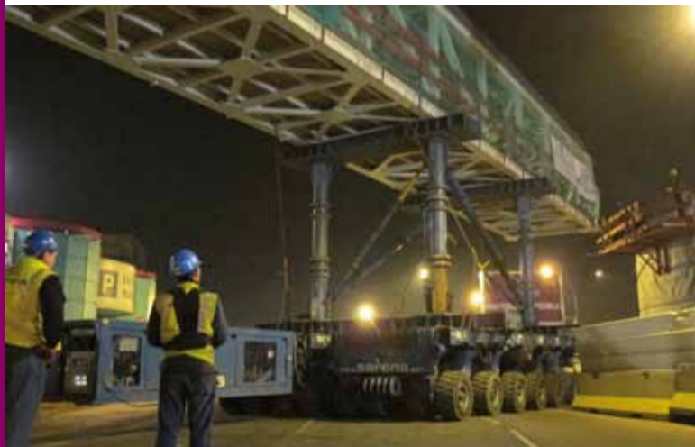
Levage de la passerelle Belle-Epine
